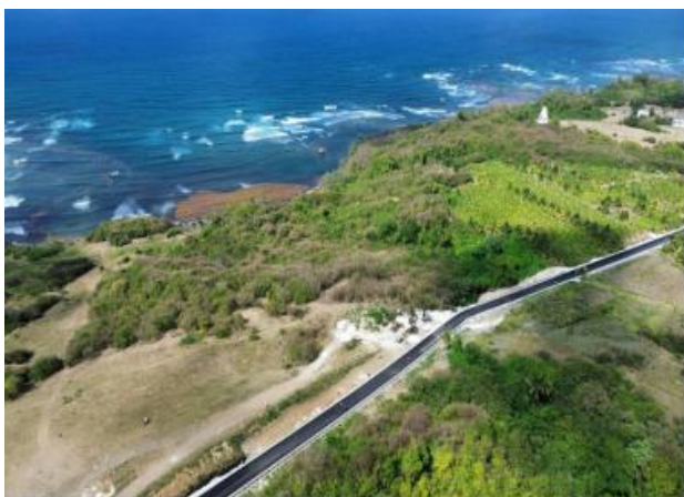
巴巴多斯苏格兰地区道路修复项目
