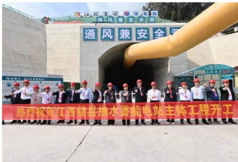
赣县抽水蓄能电站主体工程启动建设
