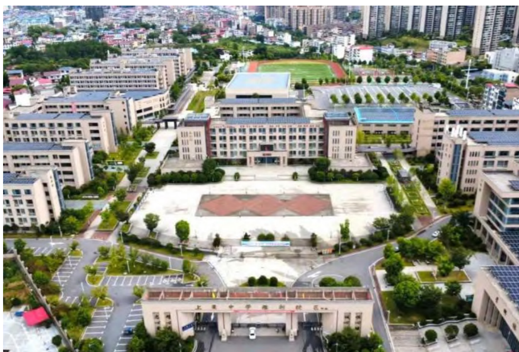
“绿色校园”分布式光伏项目现场
