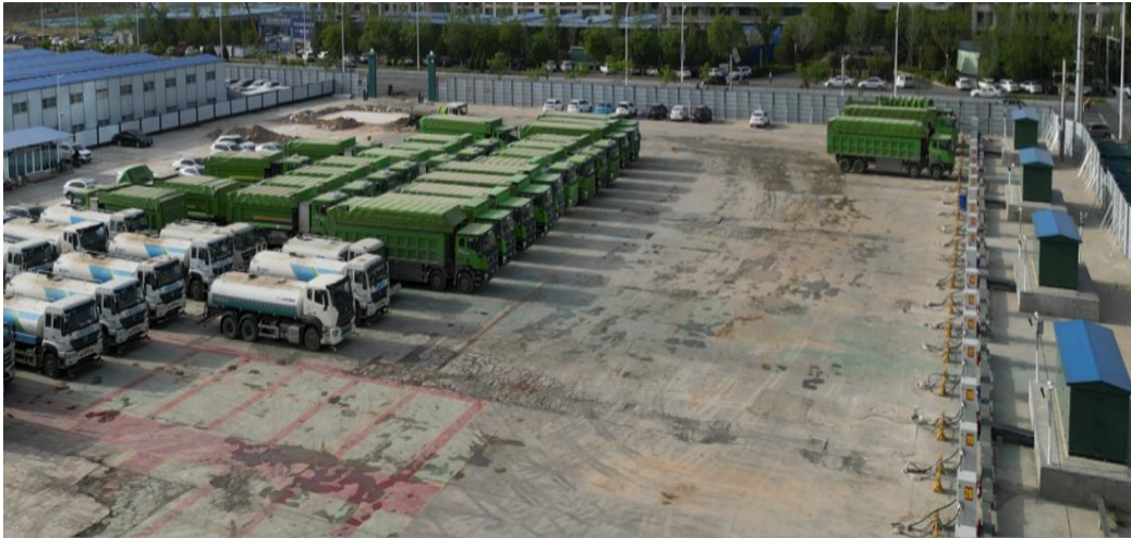
图：河北重卡项目，总功率 9600kW
