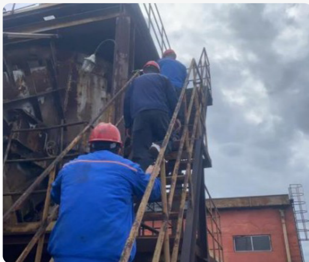
灌南金圆环保焚烧线各平台围栏完好性专项检查
