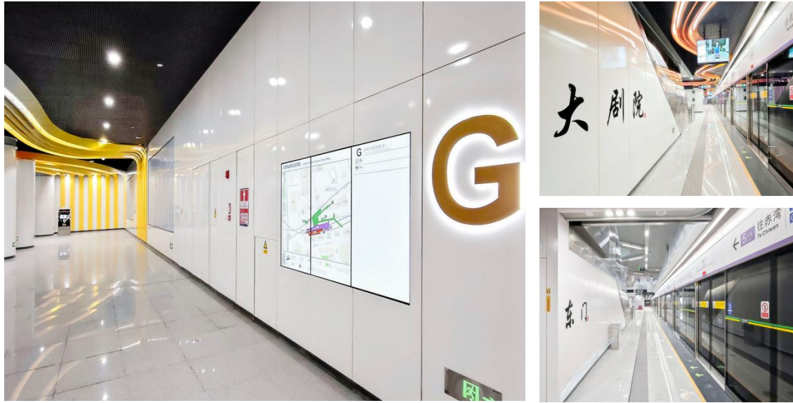
深圳地铁 5 号线西延线
