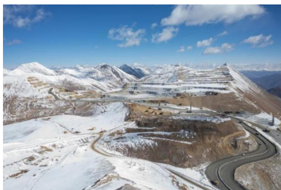
图一 西藏巨龙铜矿项目
