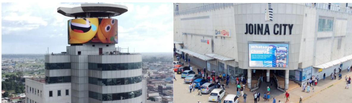
津巴布韦首都哈拉雷市中心户外 LED 显示屏项目
