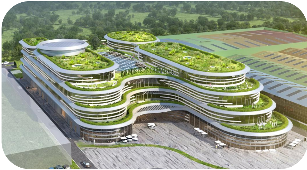
建设中的国家草业技术创新中心
