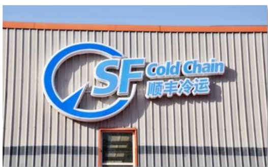
图6.36 顺丰控股冷库外观
