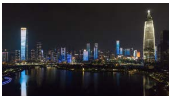
深圳湾广场景观照明工程 I 标段
