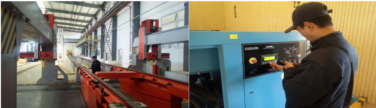
图：动车所维保现场
