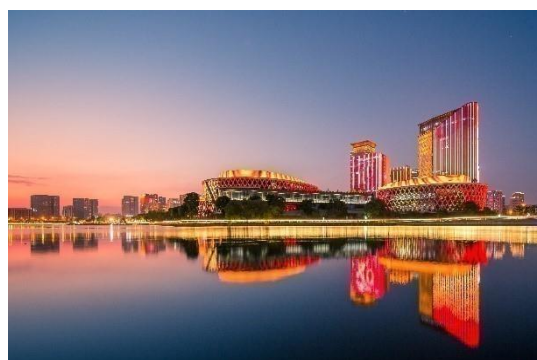
宁波镇海新城核心区亮灯工程
