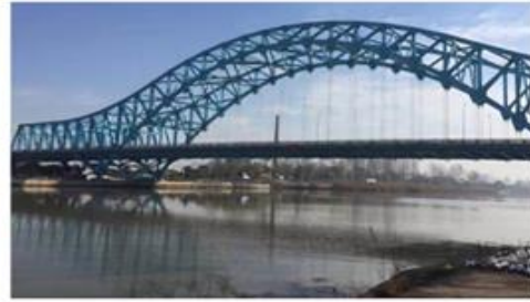
图例：泗阳城子河公路大桥
