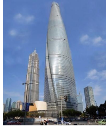
上海中心大厦使用的 防火玻璃幕墙
