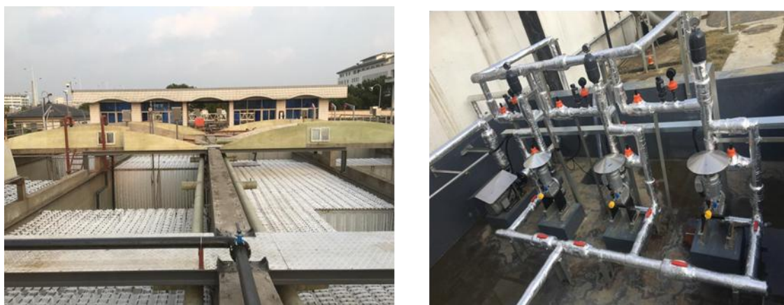
图：苏州吴中城区污水处理厂提标改造项目
