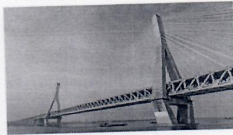
图例：天兴洲长江大桥
