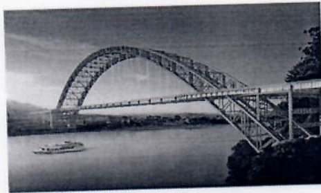
图例：四川犍为岷江大桥
