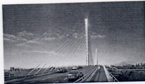
图例：上海浏港大桥
