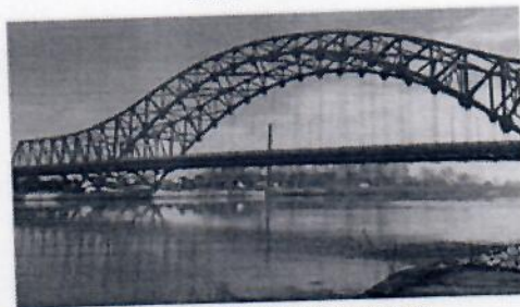
图例：泗阳城子河公路大桥
