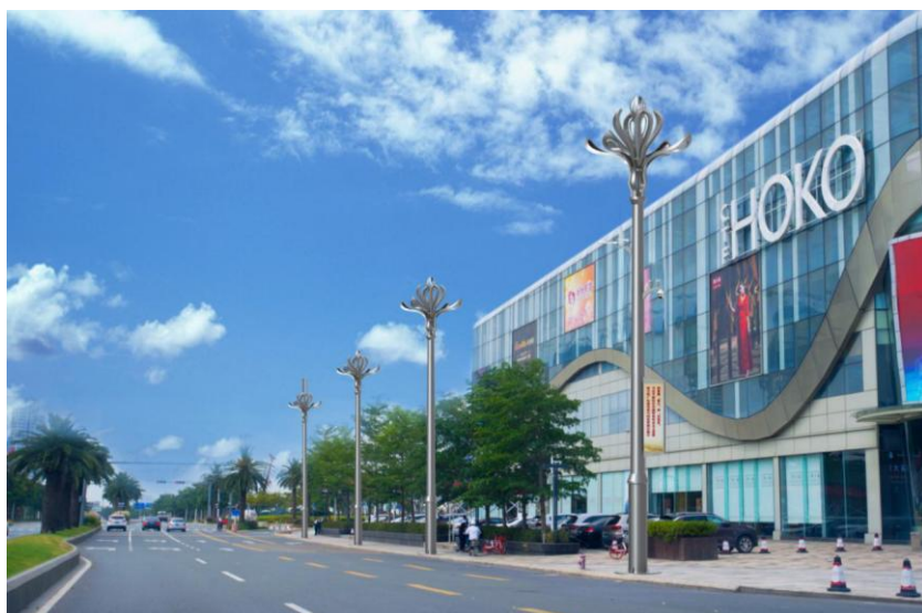
深圳市前湾一路多功能智慧杆项目
