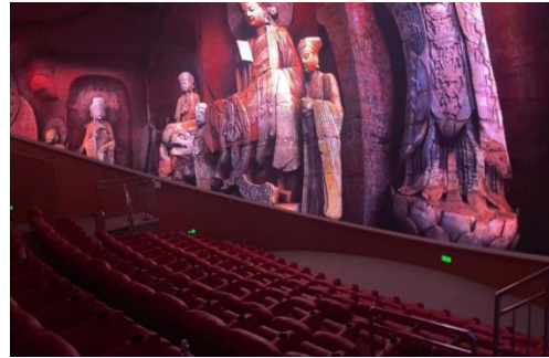
某研究院项目，内球为直径 15.6 米，点间距 1.95mm 的透声半球幕，分辨率达到 12.5K*12.5K
