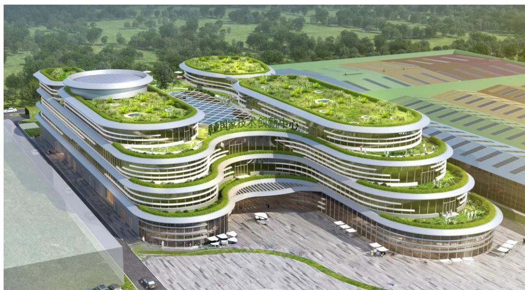
建设中的国家草业技术创新中心
