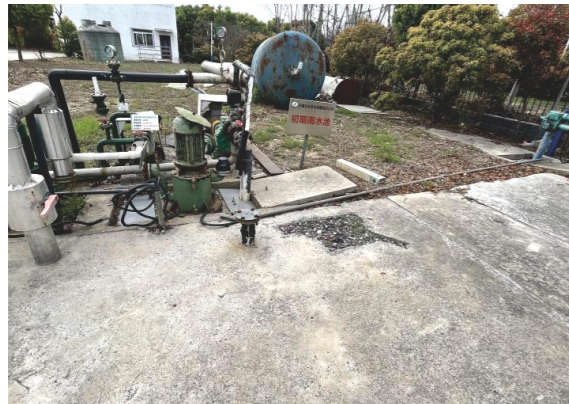
初期雨水收集池
