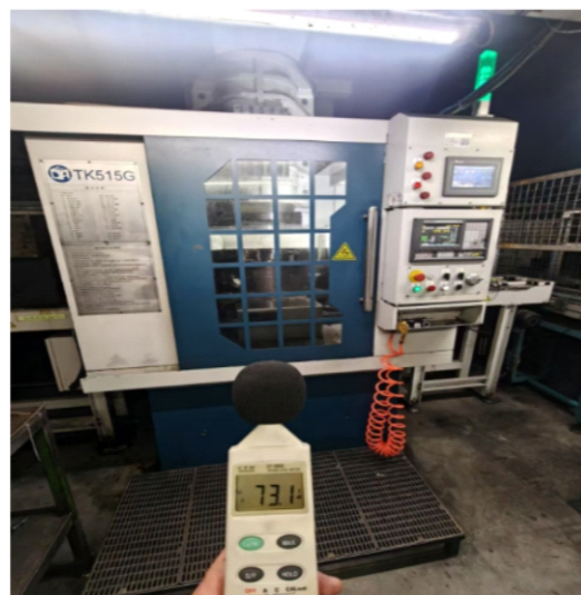
改造后高速镗孔设备
