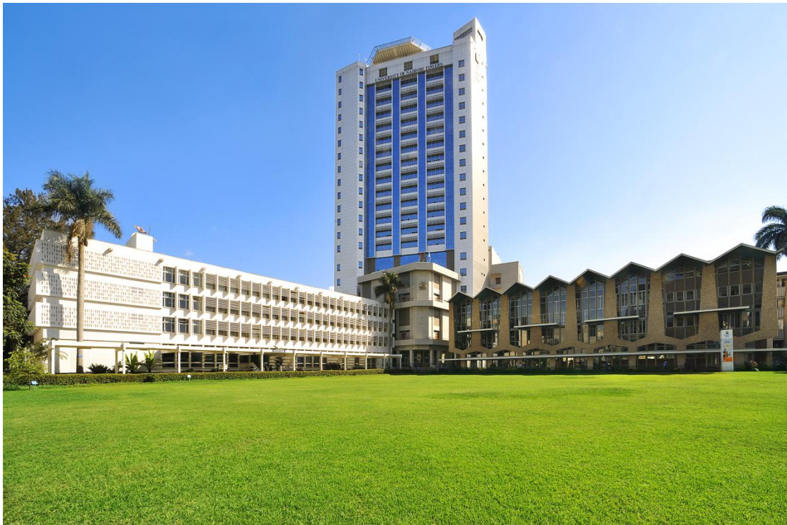
图为中国武夷承建的肯尼亚内罗毕大学综合大楼项目
