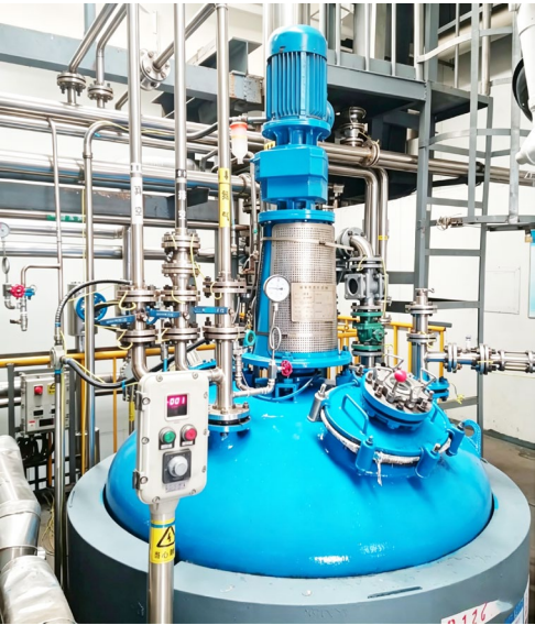
溶剂循环利用项目现场
