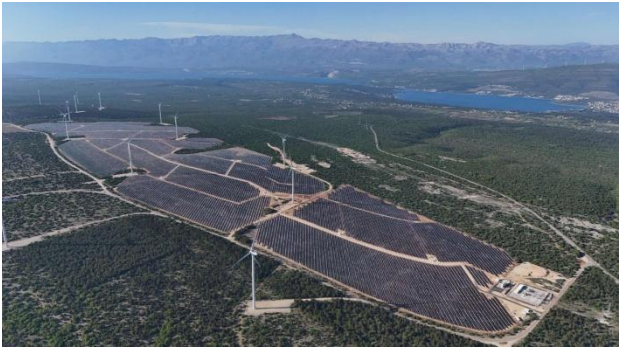
公司建设的克罗地亚科纳特 99MW 光伏项目 顺利通过克罗地亚国家验收
