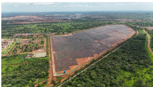
刚果（金）拉米卡源网储一体化项目 成功实现系统带负荷运行
