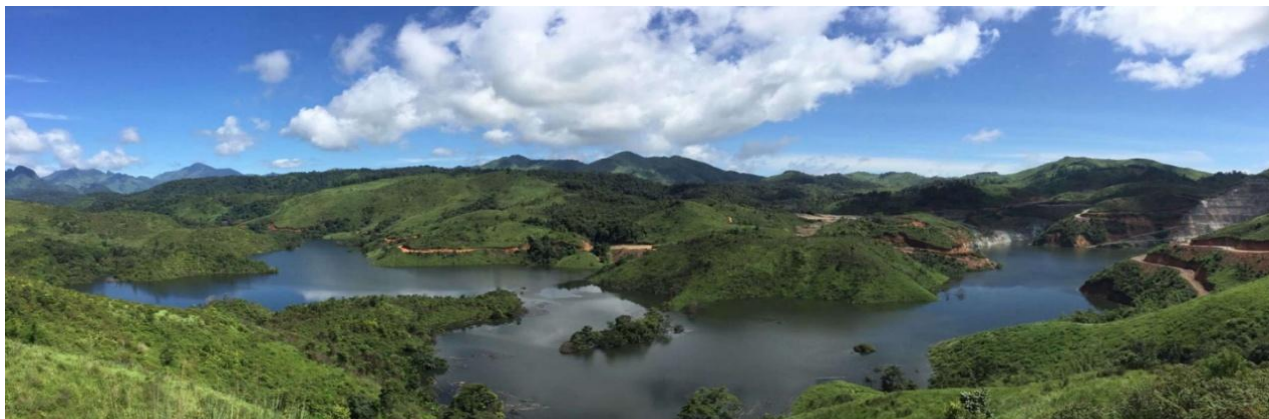
公司 BOT 项目老挝南湃水电站累计发电突破 35 亿度
