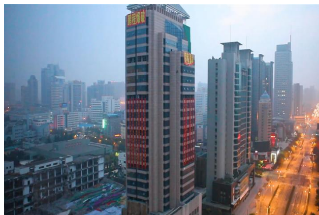
城市爆破拆除
