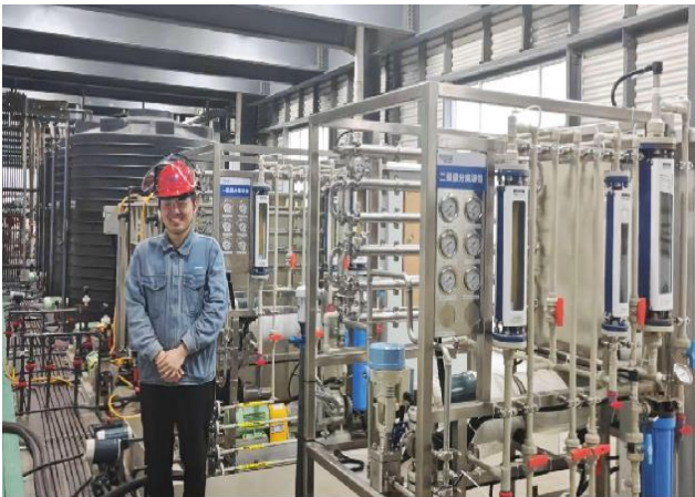
广西钦州某镍离子价值回收项目
