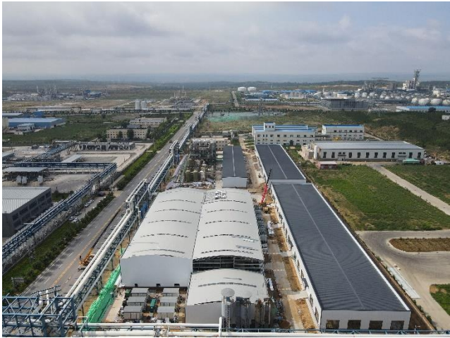
陕西榆横高盐废水运营项目
